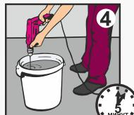
Для подготовки раствора залейте водопроводную воду комнатной температуры в чистую ёмкость из расчёта 4,5 - 5 л воды на 1 мешок (25кг). Засыпая сухую смесь в воду, перемешивайте раствор дрелью со специальной насадкой на низких оборотах до получения однородной массы. Подождите 5 минут, после этого перемешайте вторично. Время пригодности раствора к работе не менее 3 часов.
